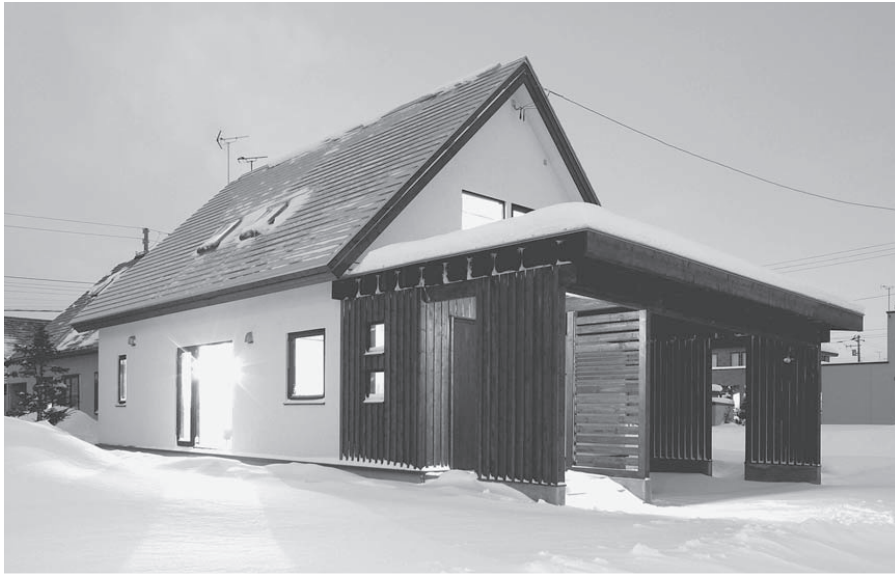
きょう22日から滝川市中島町3丁目で行う完成住宅見学会
